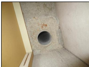
Photo N° 6 AMIANTE CIMENT Placard technique Gaz +2 Conduit de ventilation Ventilation haute (Fibres-ciment)
