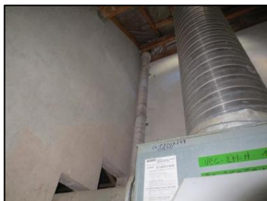
Photo N° 5 AMIANTE CIMENT Local VMC Conduit de ventilation Ventilation haute (Fibres-ciment)
